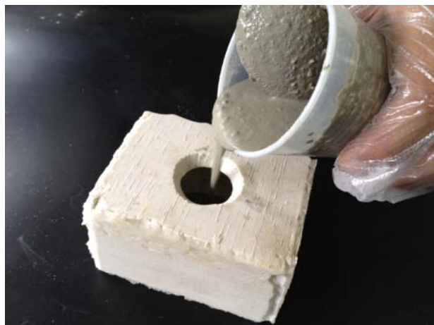
事前に準備したシリコンゴムの型に超速硬コンクリートを流し込みます。
